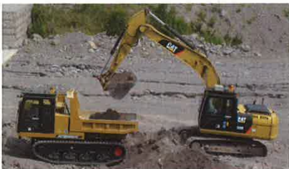
無人化施工による除石作業
