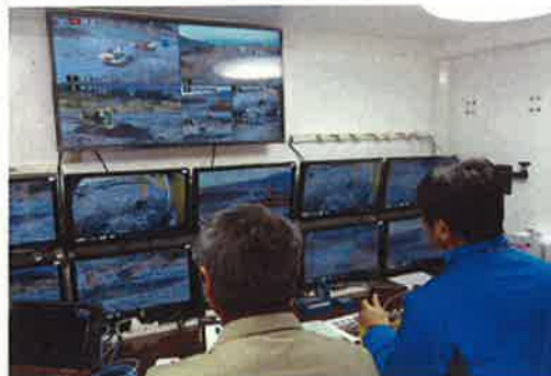
無人化施工による除石作業
