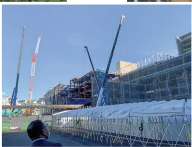
長崎駅周辺開発工事
