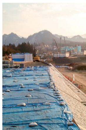
白川大橋(仮称) 工事現場写真
