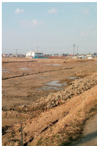
経営体育成基盤整備事業 十全地区工事現場写真
