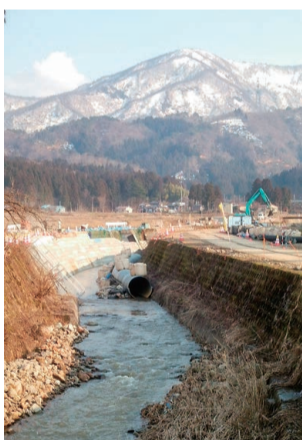
能代川改修工事現場写真
