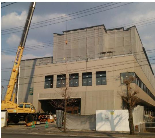
五泉中央病院建設工事現場写真
