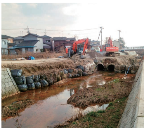
荻曾根川改修工事現場写真
