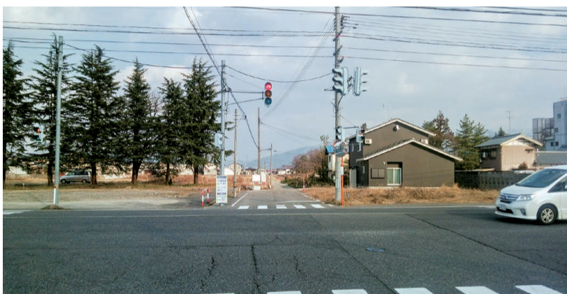
東南環状線工事現場写真 南本町
