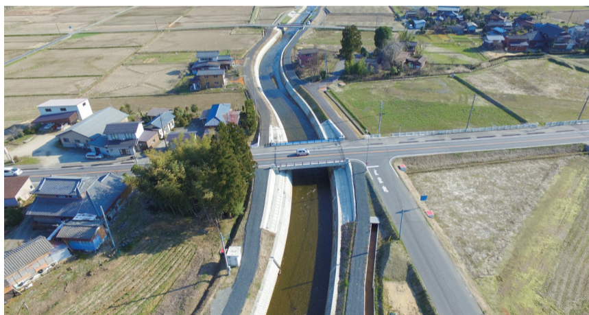
牧川中野橋地内 工事完成全景写真
