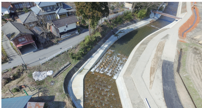
牧川栃林地内 工事完成写真
