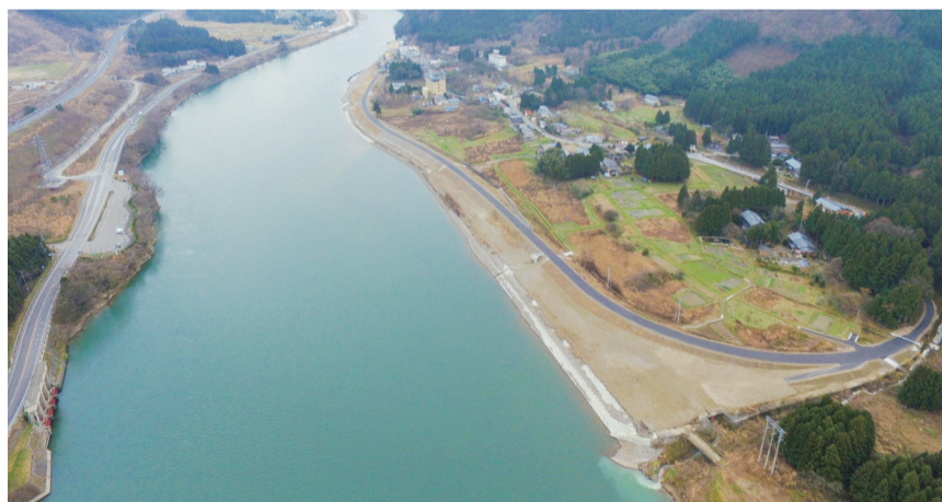
阿賀野川佐取地区 工事完成全景写真
