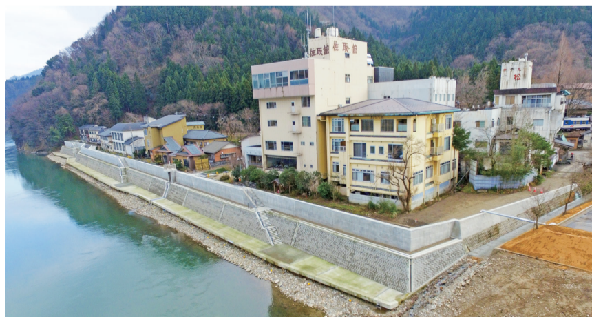
阿賀野川咲花温泉街擁壁工事完成写真
