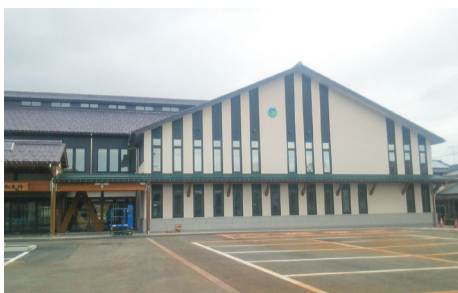
あらたに竣工した五泉市村松支所の建築には多くの木材利用により補助金を活用している。
