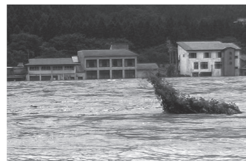
咲花地内の護岸改良 今年から始まる
