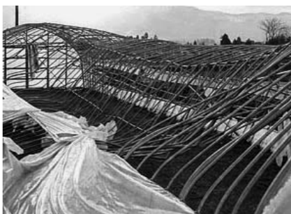
被害を受けた農業用ハウス
