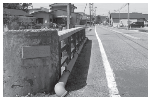
迂回仮設道路設置後つきみ橋の建設始まる
