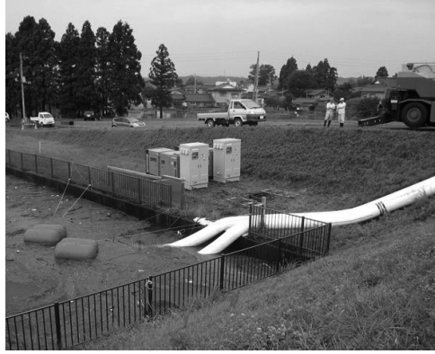
新潟福島豪雨時の太田川排水機場 (6.2t/s から 7.7t/s に排水能力アップ。H25 着手)
