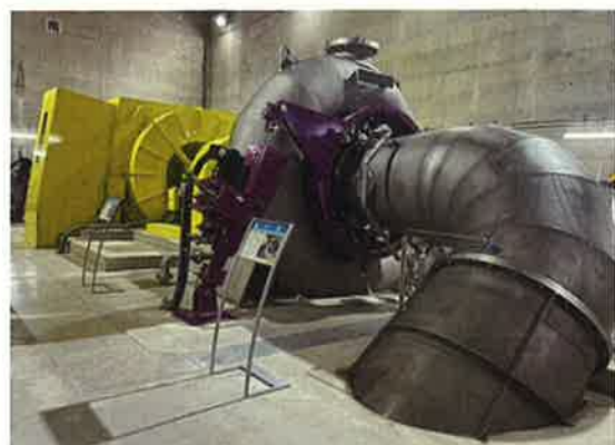
横軸同期発電機（黄色部分）と横軸両掛フランシス水車（群馬県HPより）
