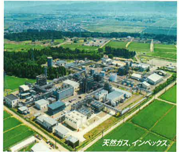
長岡鉱場 越路原プラント全景（同社 HP より）
