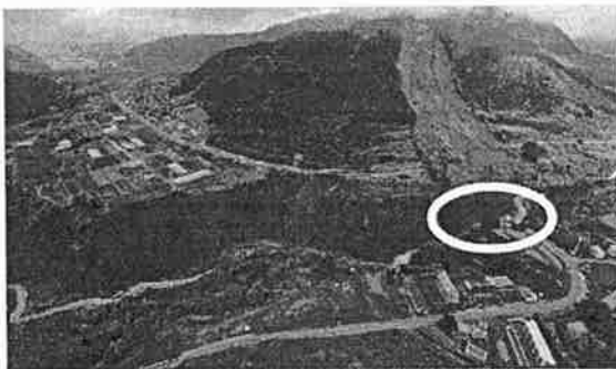
写真 左：毎日新聞HPから （崩壊箇所の写真・平成 28 年 4 月 22 日）
