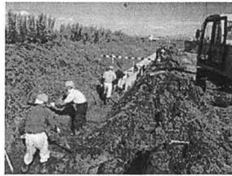
自主施工の様子
