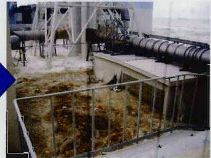
海拔約10mの敷地にある高さ5.5mの重油タンクが水没
