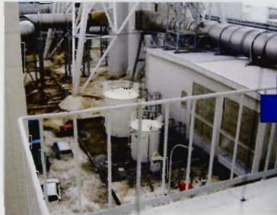
海拔約10mの敷地にある高さ5.5mの重油タンクが水没
